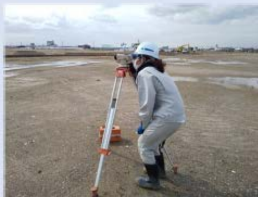
測量をするベトナムエンジニア (土木施工管理者)
